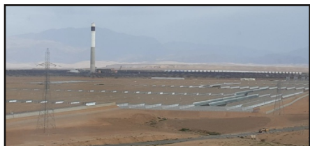
Centrale Noor à Ouarzazate
